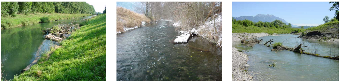
Abb. 4: In den Liechtensteiner Binnenkanal eingebrachte Totholzstrukturen; von links nach rechts: Teststrecke bei Ruggell, Rundholzstrecke bei Triesen, revitalisierter Mündungsbereich in den Alpenrhein.
