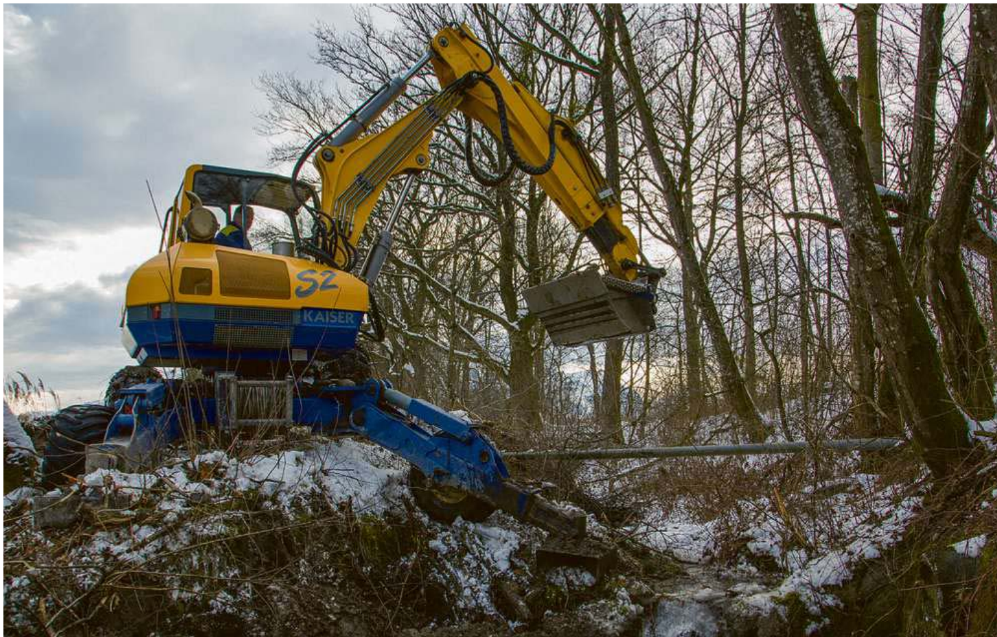
Bald können Wasserlebewesen den Tentschgraben über eine sechs Meter lange Rampe statt eine Schwelle erreichen. Bild: Rainer Kühnis
