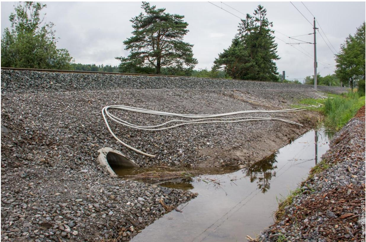
Abb. 5: Neu gestalteter Durchlass mit Kiesohle. Dieser Gewässerabschnitt wurde kurz nach den Abschlussarbeiten von Elritzenschwärmen besiedelt.
