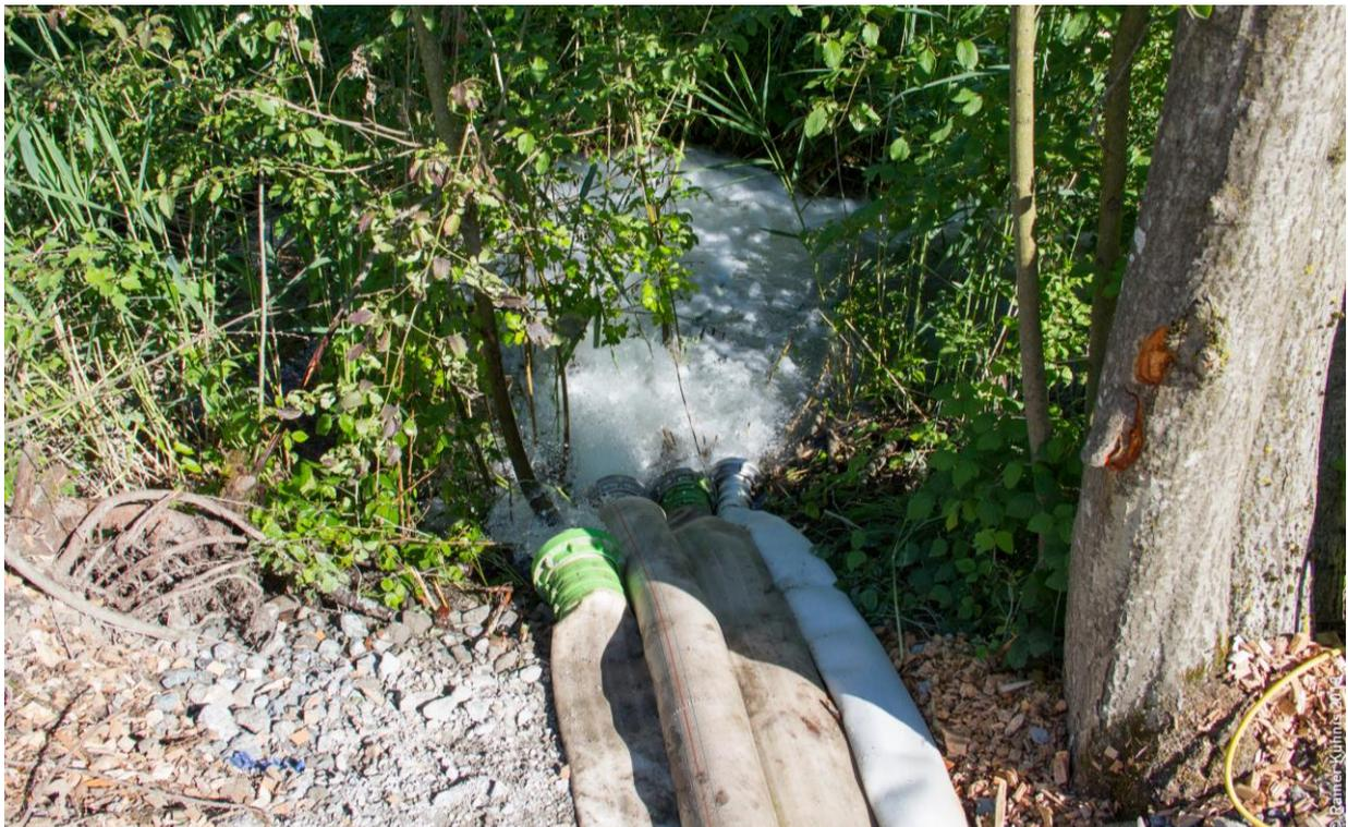
Abb. 10: Während dem Neubau des Durchlasses wurde der Scheidgraba mittels Pumpen und Schläuche über den Bahndamm „umgeleitet“.
